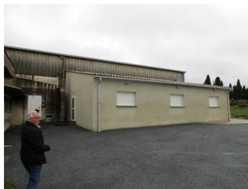
Vue arrière, vers chaufferie fioul principale
